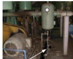
水冷式后部冷却器
