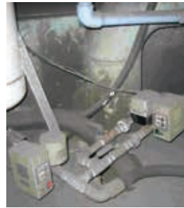
末端排水阀 铸铁厂 1991年 ~
