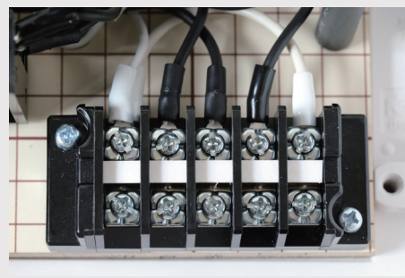
バルブなどを簡単に 接続・制御できる端子台
